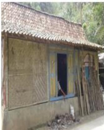
Gambar 10. Dinding rumah produksi growol sebelum di renovasi
